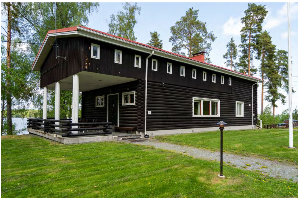
Kuva 52. Hakapirtin päärakennus (kuvaaja Tommi Käppi)
