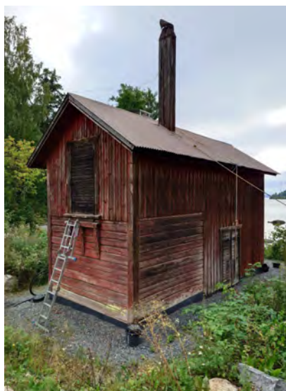
Kuva 75. Heritynniementie 138 aittarakennus (kuva Valkeakosken kaupunki)
