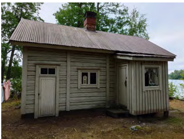
Kuva 77. Kuva kiinteistöllä 908-410-1-104 sijaitsevasta rakennuksesta
