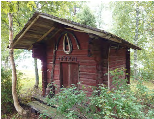
Kuva 74. Heritynniementie 138 aittarakennus (kuva Valkeakosken kaupunki)
