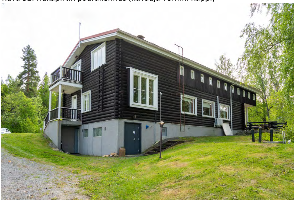
Kuva 53. Hakapirtin päärakennus (kuvaaja Tommi Käppi)
