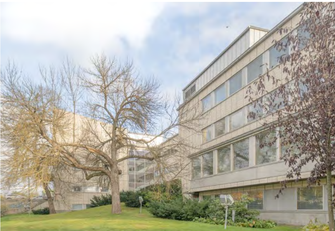
Kaupungintalo hahmottuu tästä kuvasta hyvin kahdeksi massaksi, A- ja B-siiveksi. Tästä näkökulmasta myös B-siiven IV-konehuone erottuu selkeänä, joskin loogisena osana rakennusta. Kuvasta näkyy myös hyvin, miten runsas rakennuksen ikkunapinta-ala on. Aukotus tuo valoa työhuoneisiin ja avaa erinomaiset näkymät kulttuurimaisemaan.
