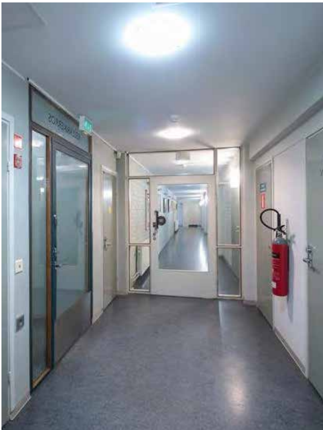
Näkymä vastakkaisesta suunnasta. Kellarikerroksen tilat ovat olleet aina pääosin henkilökunnan käytössä. Vasemmalla B-siiven porrashuone.
