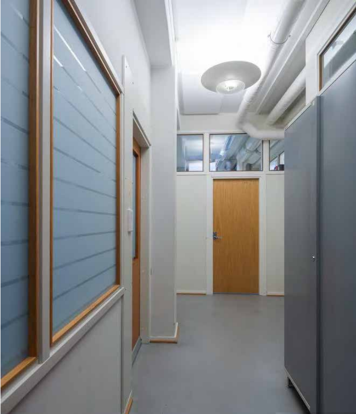
B-siiven 1. kerroksen 2000-luvulla muodostettua käytävää. Taustalla varastohuone.
