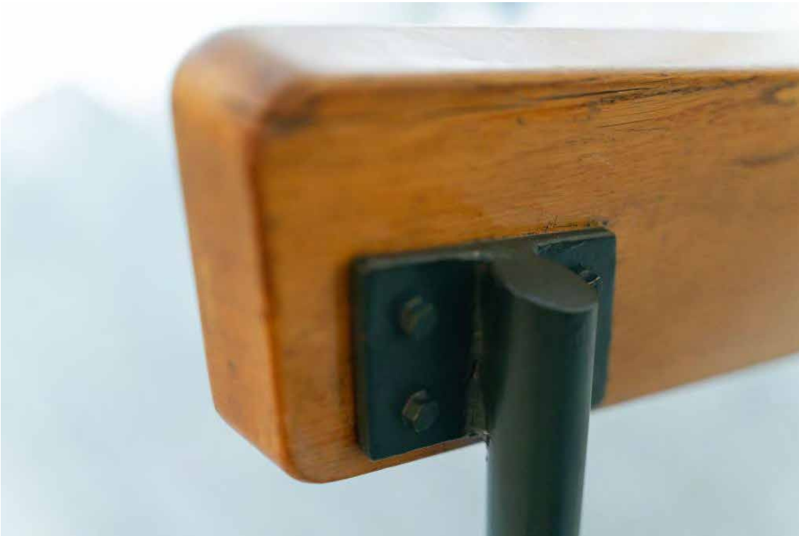
Yksityiskohta kädensijan kiinnityksestä.
