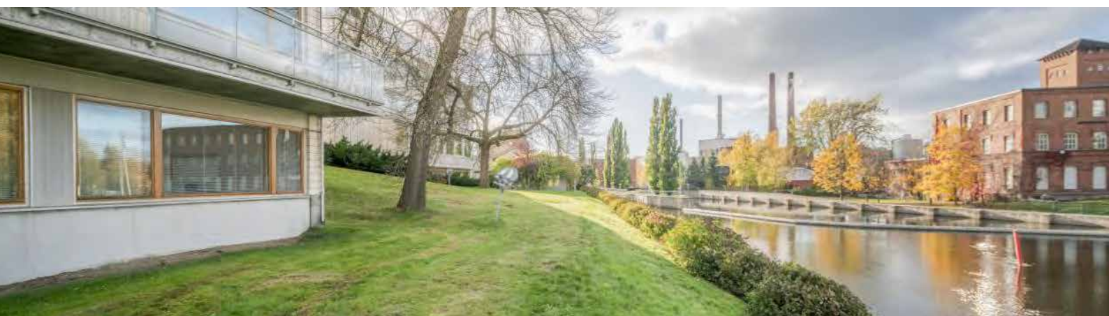
Panoraamakuva kellarikerroksen kulmalta ja kanavan alueelta.
