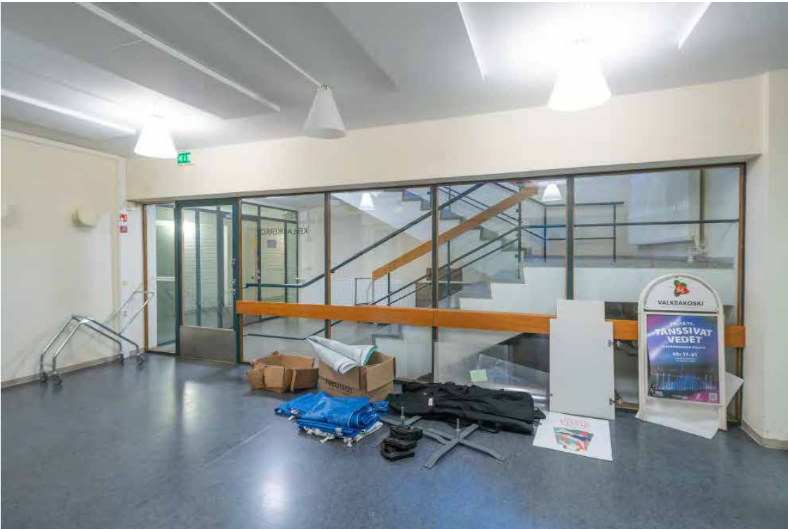
Kellarikerroksen tilavaa aulaa. Aula oli ennen peruskorjausta käytännössä kaksinkertainen ja siellä lienee ollut vastaanottotiskin lisäksi mm. vastaanottokalusteita veroasioissa odottaville.
