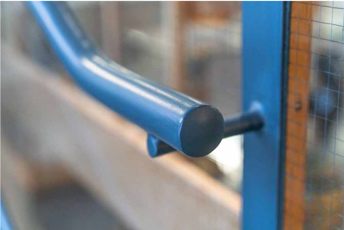
Portaiden ja muiden tilojen metalliosat ovat pääosin alkuperäisiä.
