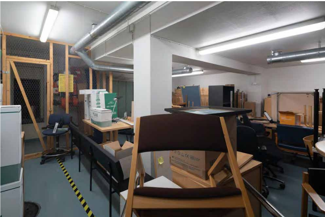
Näkymä väestösuojusta, joka toimii lähinnä huonekaluvarastona. Vasemman häkkikomeron sisällä väestösuojan ilmanvaihtolaite ja hätäuloskäytävä Sääksmäentielle.
