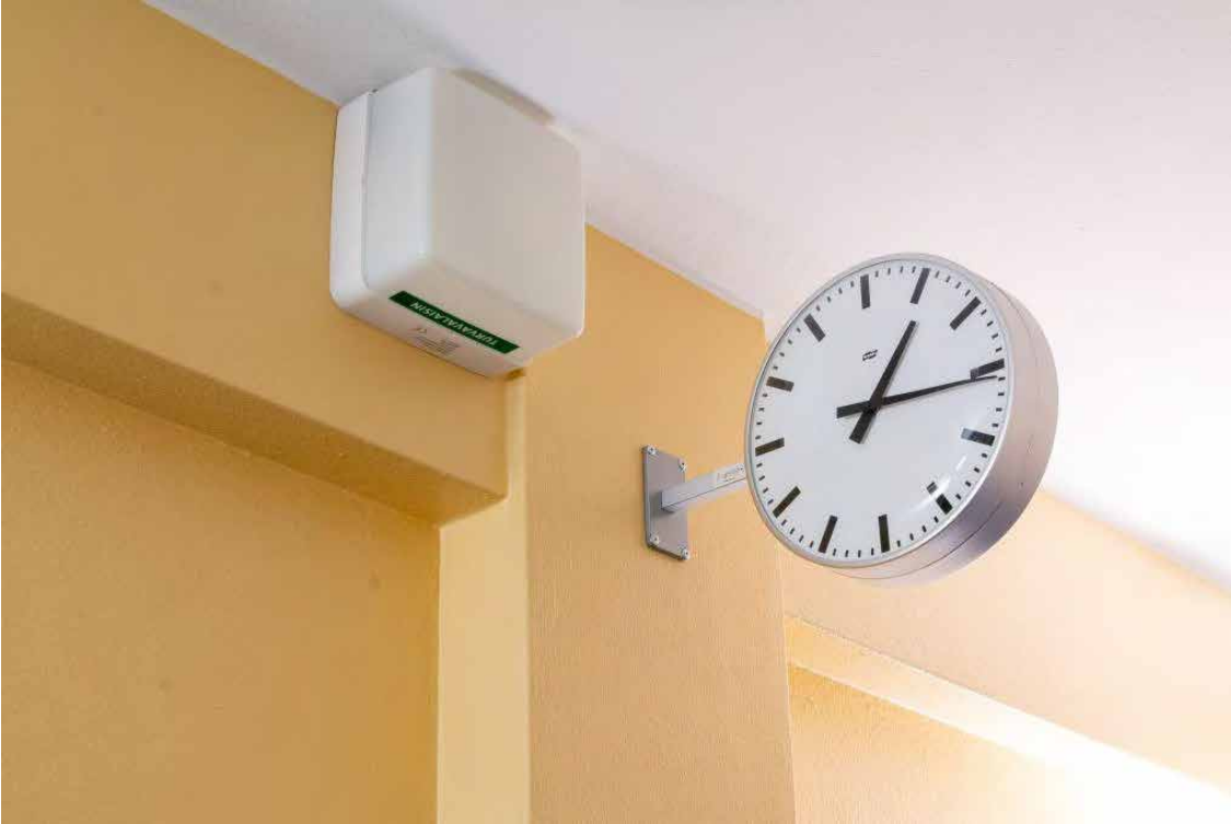
Toisen kerroksen käytävän yksityiskohtia: kello ja hätäpoistumisvalo.
