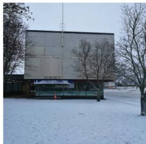
Kanavanrannan huonokuntoiset rakennukset pistävät silmään! #kanavanrantano #Valkeakoski #keskustauudistus #building #reform #cityplan
