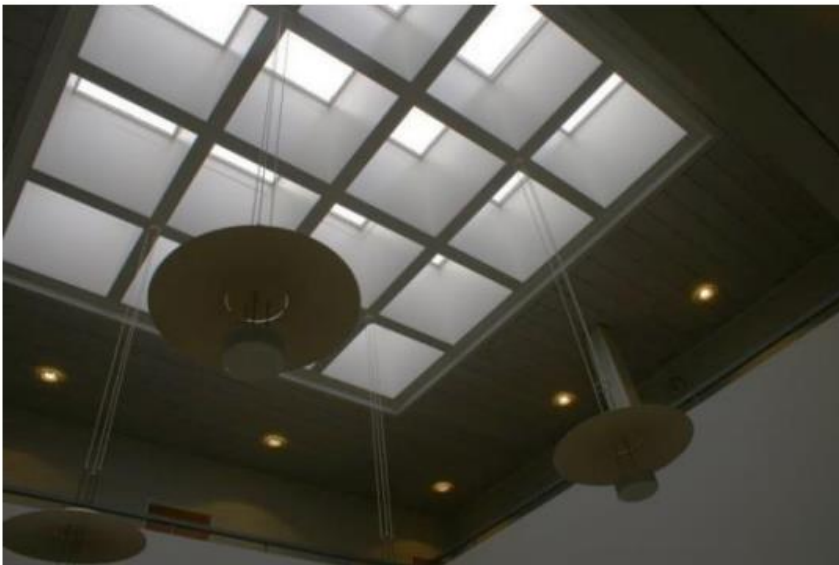
Selvityksen kuva 170. Yllä ja keskellä linja-autoaseman eteläjulkisivu, alla odotusaulan katto. Pikkukuvissa yllä parkkihallin sisäänajo ja alla tavaratalon julkisivun yksityiskohtia.
