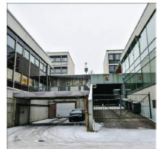
Kanavanrannan huonokuntoiset rakennukset pistävät silmään! #kanavanrantano #Valkeakoski #keskustauudistus #building #reform #cityplan
