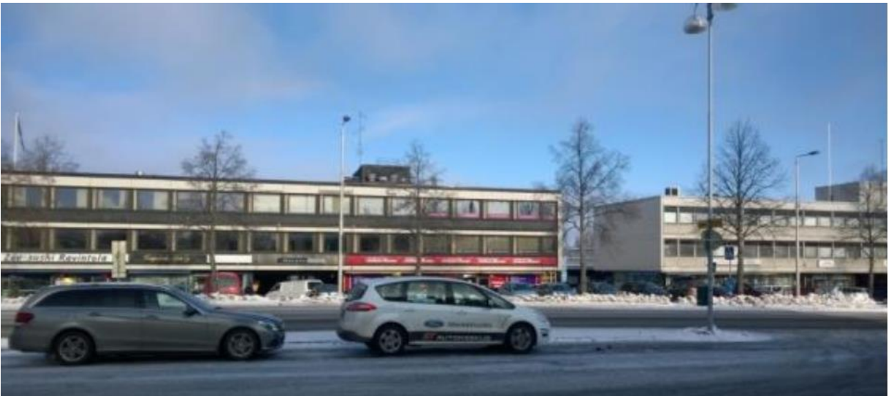
Selvityksen kuva 168. Apiankatu 3:n ja 5:n kadun puoleiset julkisivut
